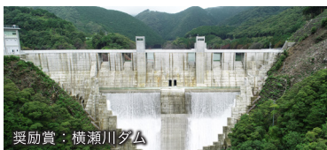
奨励賞：横瀬川ダム
